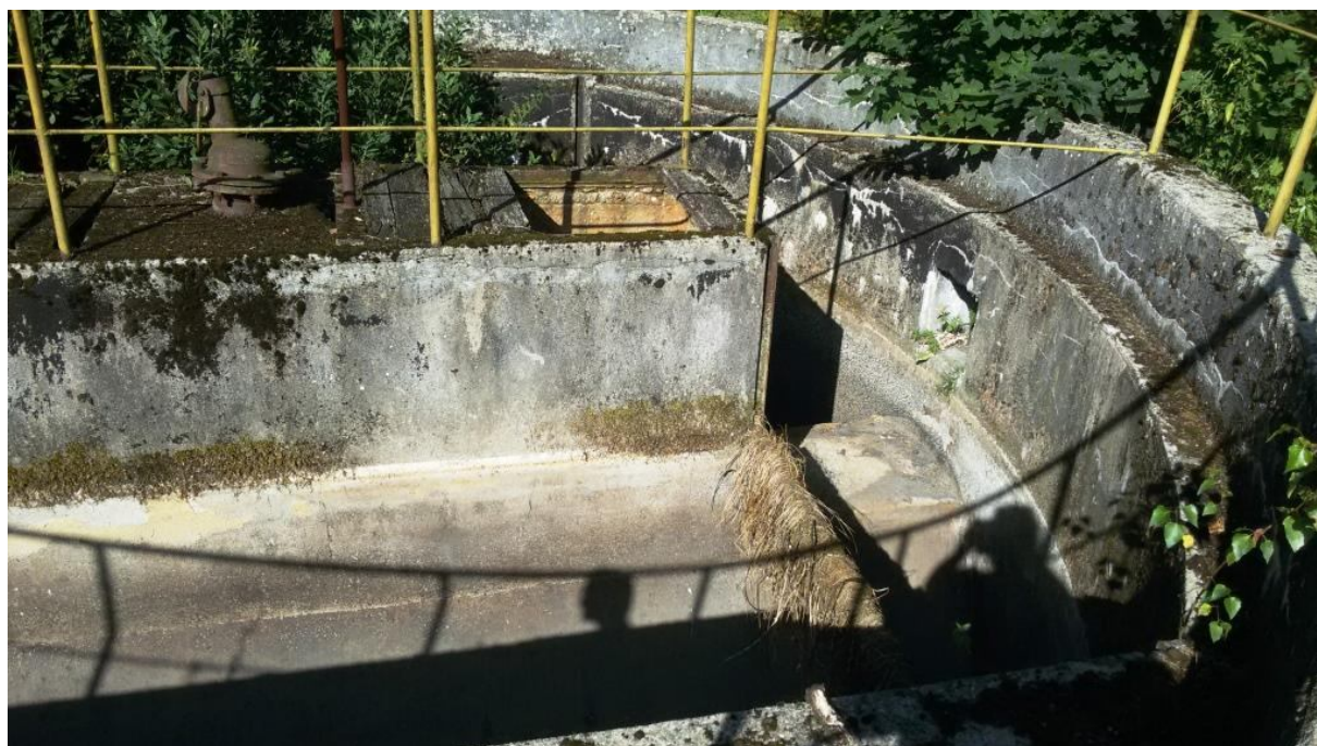
PŮVODNÍ ČOV PRO VYUŽITÍ NA DEŠŤOVOU ZDRŽ
