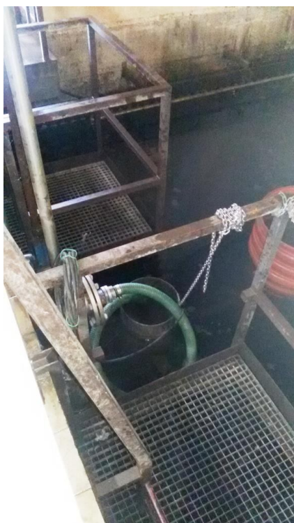
CHYBĚJÍCÍ ČERPADLO VRATNÉHO KALU A JEHO CHYBĚJÍCÍ JEŘÁBEK
