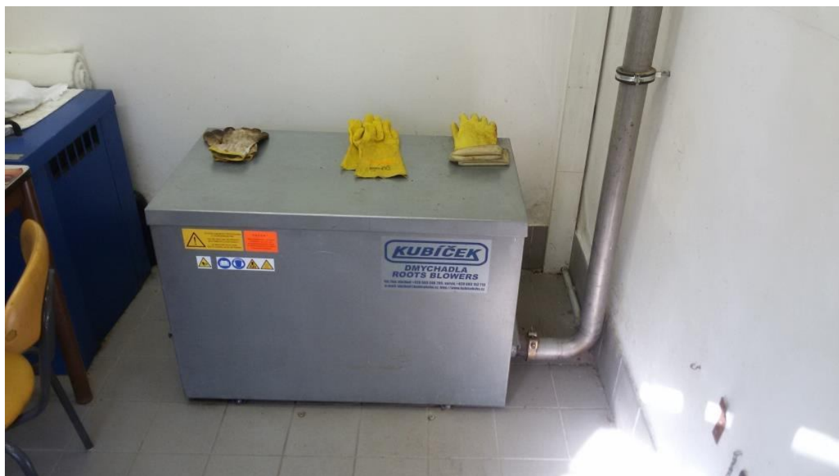
JEDNO PROVOZNÍ DMYCHADLO BEZ ZÁLOHY
